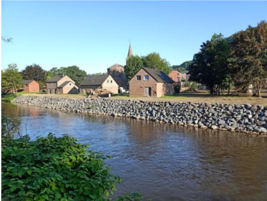
Nouveaux enrochements sur la Vesdre.
