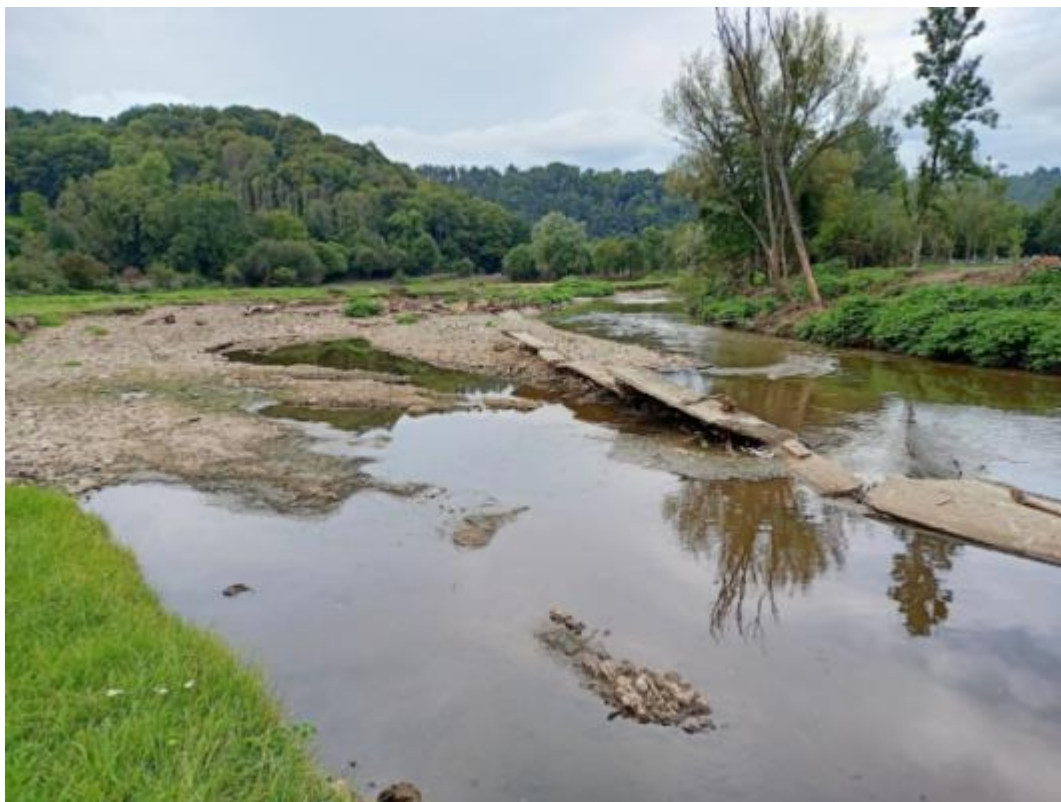
Anse d'érosion creusée dans la réserve naturelle domaniale de Goffontaine.
