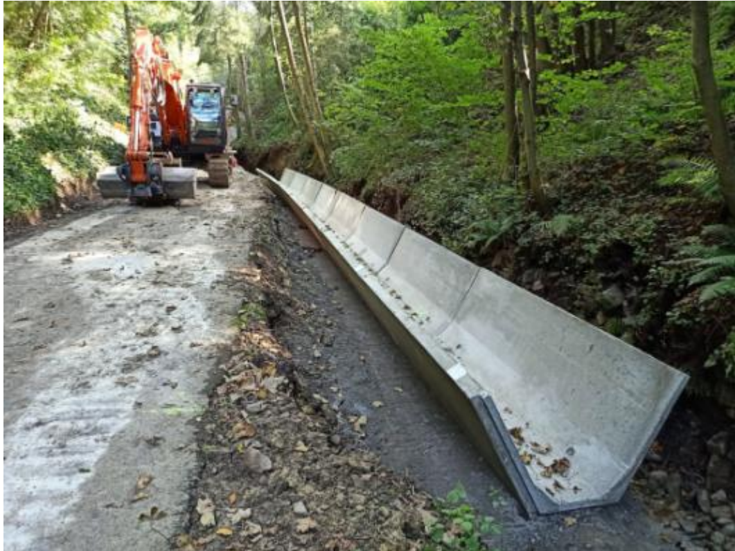
Le Ry de Chenal, affluent de la Vesdre, en cours de canalisation sur 300 mètres.
