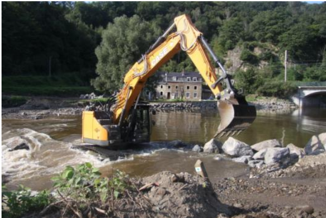
Travaux dans le lit de la Vesdre – aménagement d'un passage à gué temporaire en vue d'accéder à la cité de La Fenderie (Trooz).
