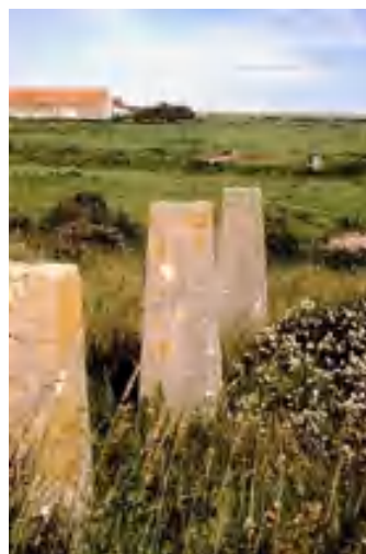
piliers de béton
