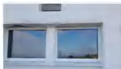
Nouvelle porte et nouvelles fenêtres à la salle de la briquetterie qui offre désormais une magnifique vue sur mer !
