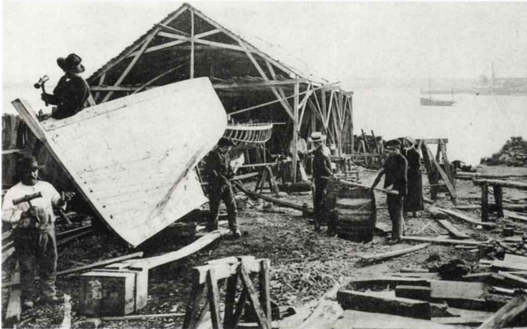
Chantier de construction à Étrel (Morbihan).
