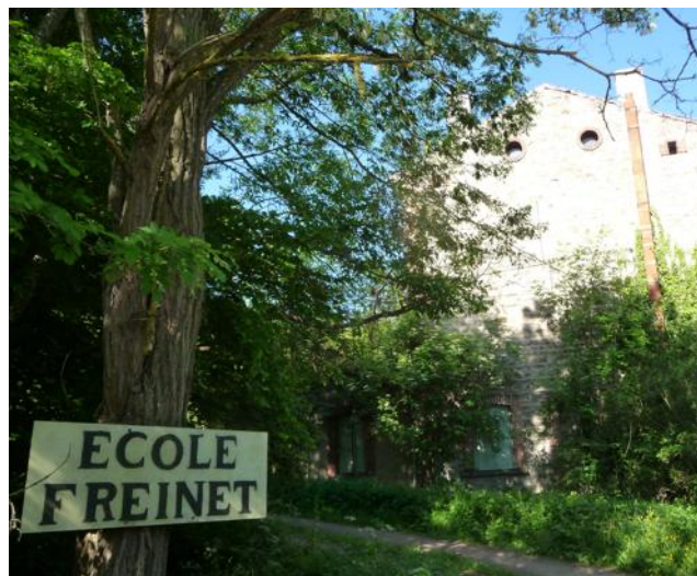
■ Depuis l'incendie de décembre 2004, la maison de Renée Coquard est complètement à l'abandon. Photo Henry Flagey
