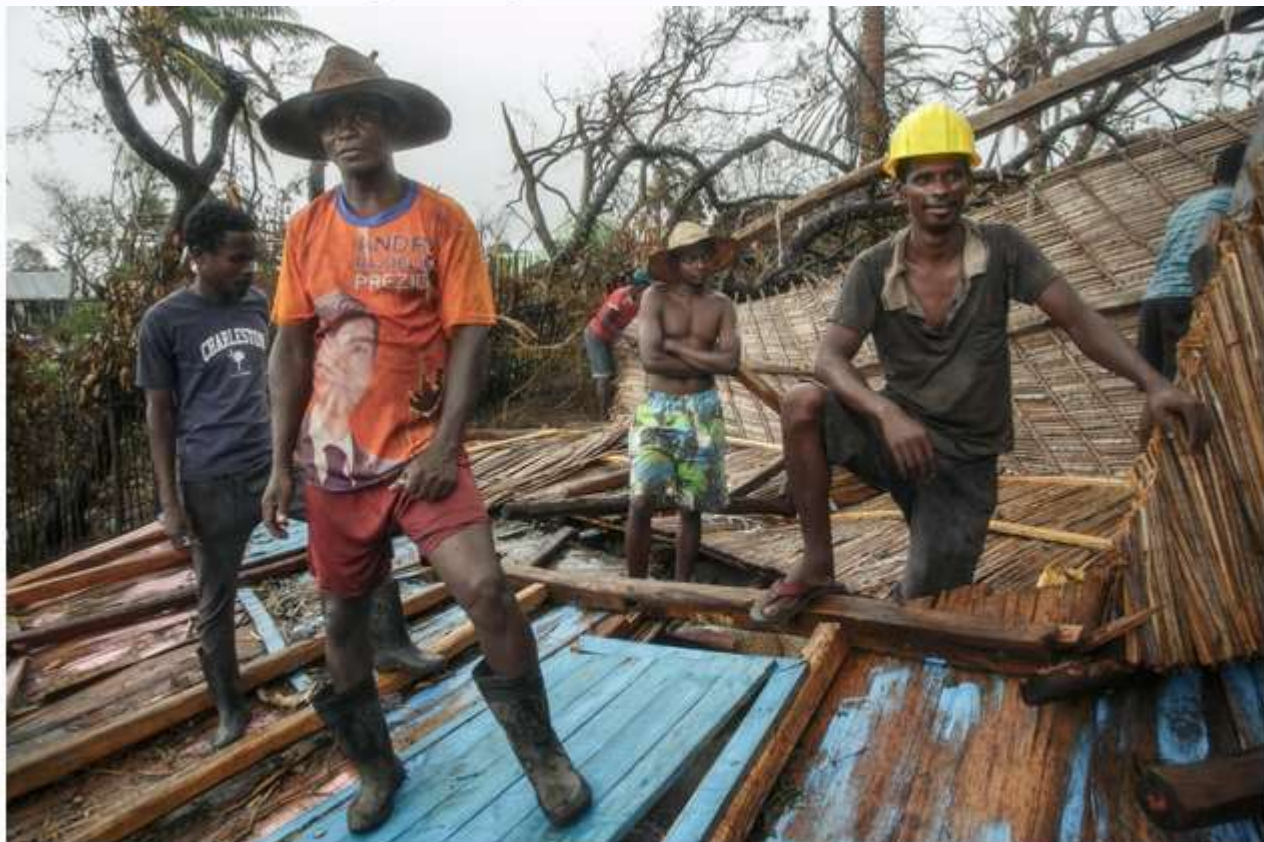
Des habitants de Mananjary, sur la côte est de Madagascar, nettoient les débris de leurs maisons après le passage du cyclone Batsirai, le 8 février 2022. L'un d'entre eux porte un tee-shirt à l'effigie du président Andry Rajoelina. RIJASOLO / AFP
