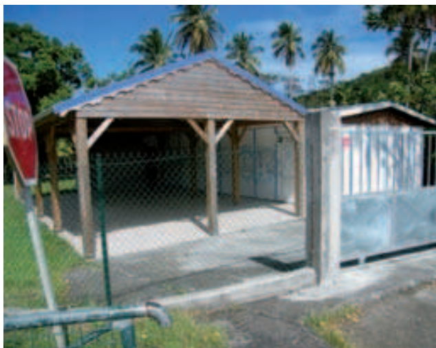
Maison de quartier de RIFFLET sécurisée
